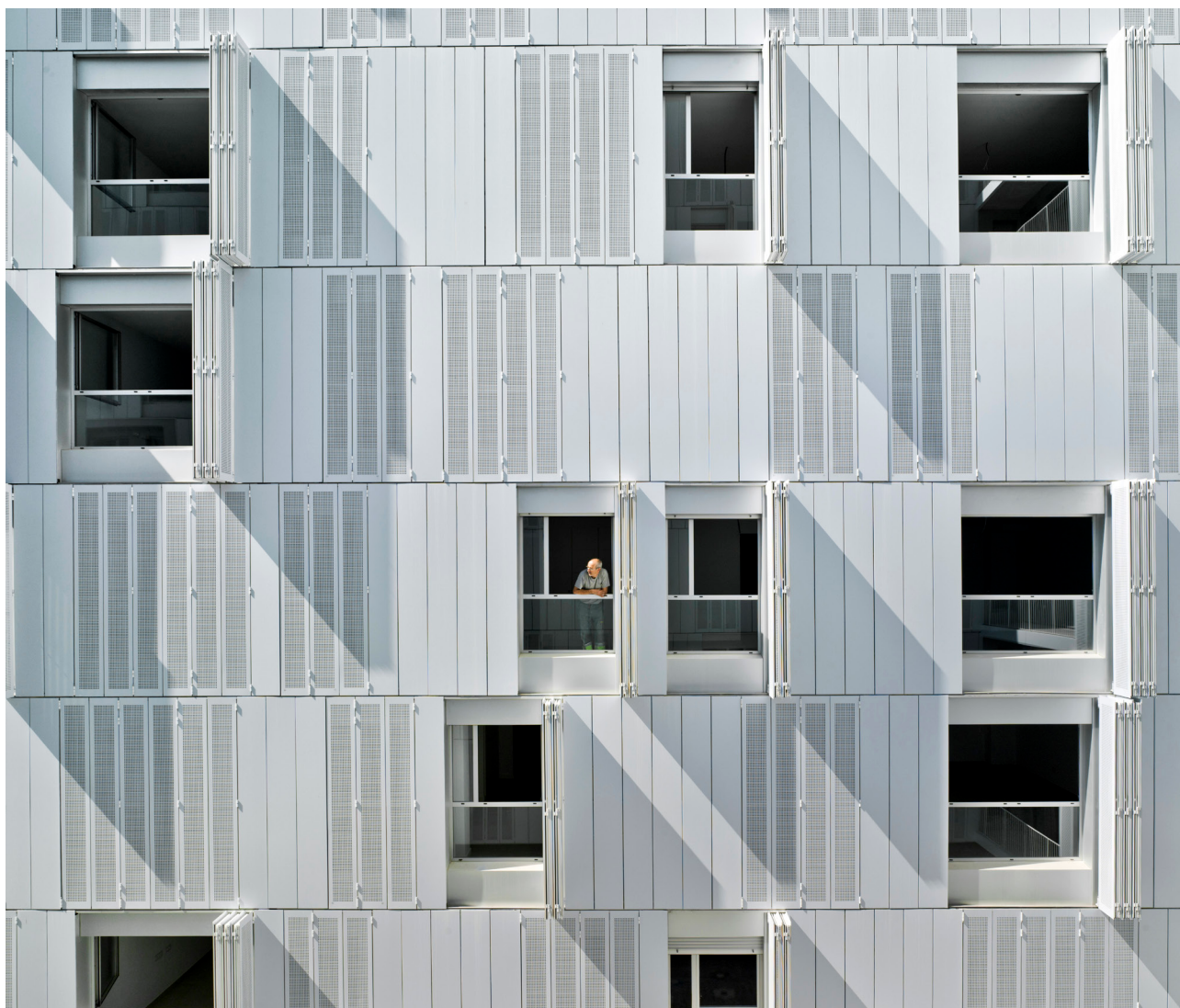
La envolvente del edificio reproduce un gran lienzo blanco con paños opacos y translúcidos resuelto con panel composite CORTIZO
